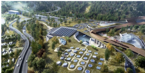
延慶賽區綜合能源項目
