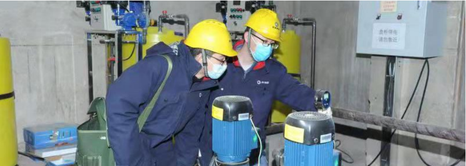
奧運配套綠電供熱項目實圖與綠電供熱項目圖解
