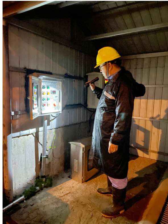
防汛排查現場
