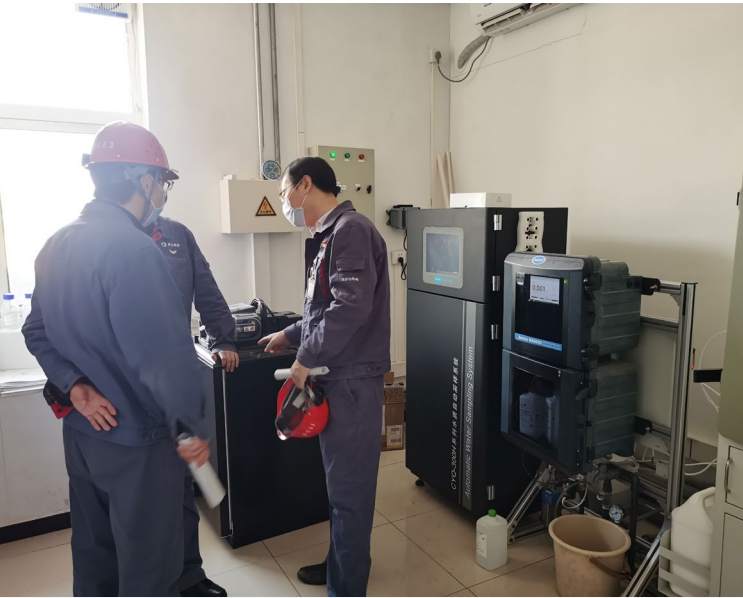
廢水監測設備檢查現場
